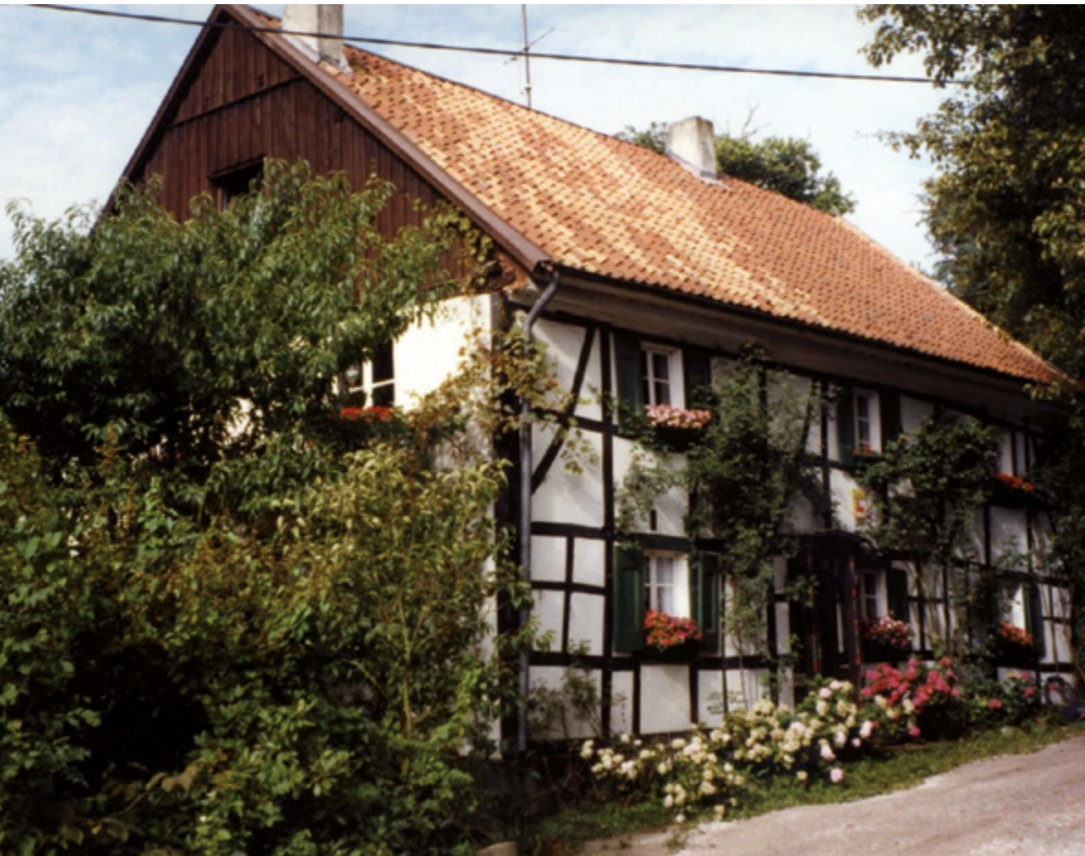
Das Fachwerkhaus vor der Sanierung, Ostseite
